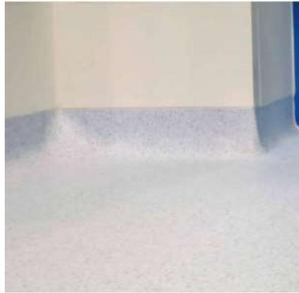
**Figura 3: Detalle del zócalo sanitario curvo y que guarda continuidad con el piso.**
